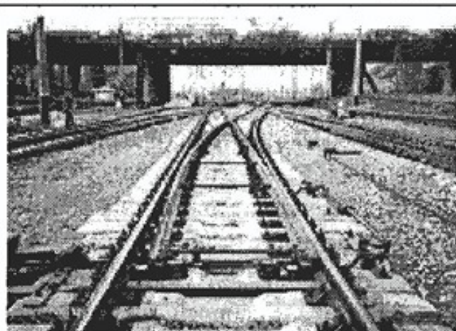
Рис. 1 — Опытный образец стрелочного перевода типа Р65 марки 1/9 колеи 1520 мм с пониженным износом конструктивных элементов
